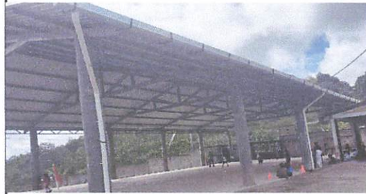
Foto 2: COLOCACION DE CANAL
