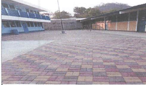
Foto 3: COLOCACION DE ADOQUIN.
