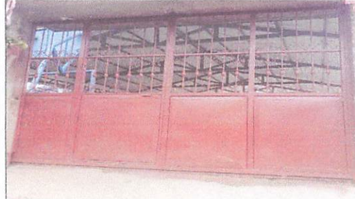
Foto 4: NUEVO PORTON DE INGRESO
