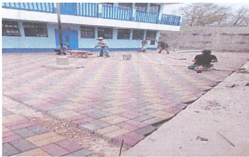
Foto 3: COLOCACION DE ADOQUIN.
