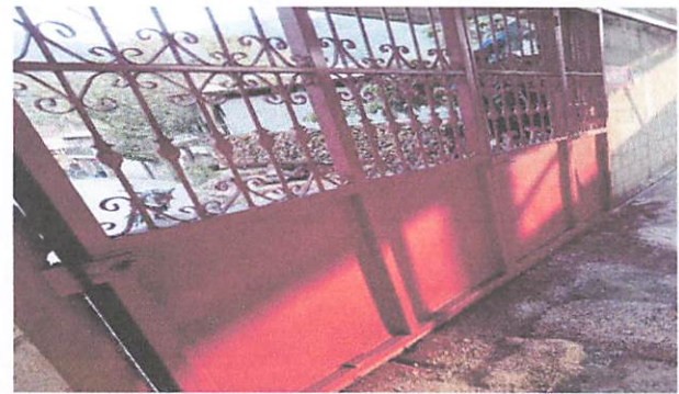
Foto 4: COLOCACION DE PORTON DE INGRESO
