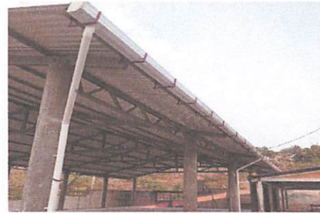
Foto 2: COLOCACION DE CANAL Y REFUERZO Y REMACHES EN TRANS LAPES
