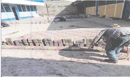
Foto 1: Foto 3: COLOCACION DE PLANCHA DE CONCRETO A COLOCACION DE ADOQUIN.
