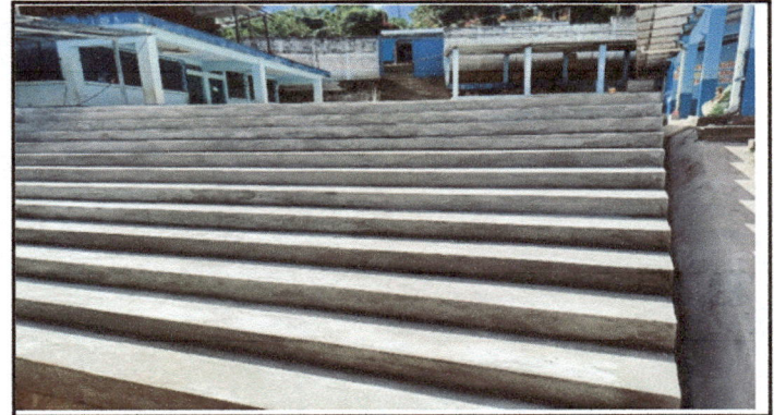
Foto 4: SUMINISTRO DE GRADERÍO PROTECCIÓN TALUD.
