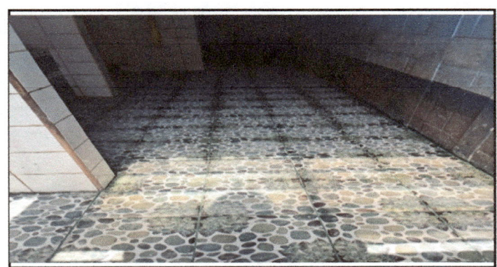
Foto 6: SUMINISTRO DE PISO CERAMICO DE SANITARIOS.
