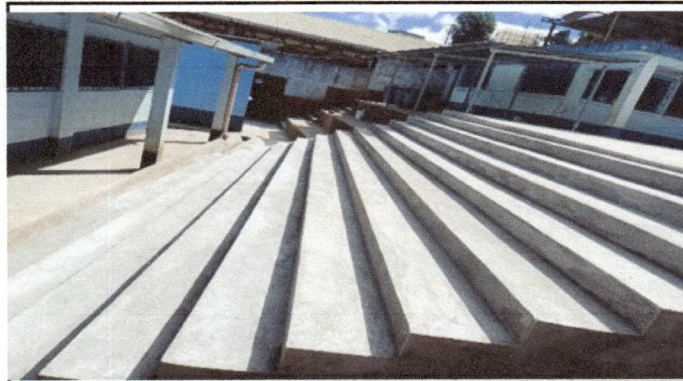
Foto 3: SUMINISTRO DE GRADERÍO PROTECCIÓN TALUD.
