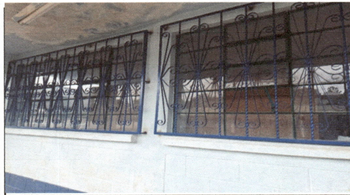
Foto 5: SUMINISTRO DE BALCONES DE AULAS.
