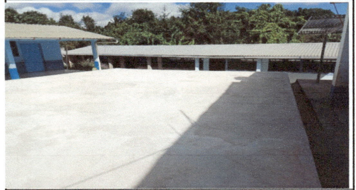
Foto 2: SUMINISTRO DE PISO DE TORTA DE CONCRETO PARA PATIO.
