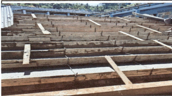
Foto 3: SUMINISTRO DE GRADERÍO PROTECCIÓN TALUD.
