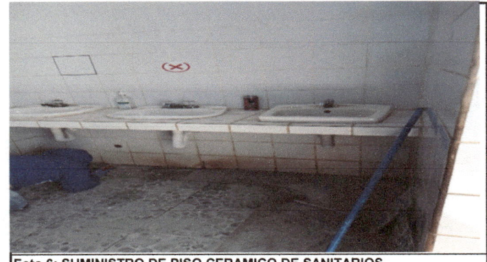
Foto 6: SUMINISTRO DE PISO CERAMICO DE SANITARIOS.
