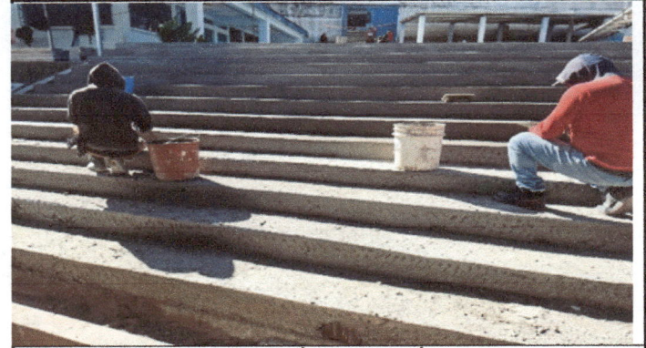
Foto 4: SUMINISTRO DE GRADERÍO PROTECCIÓN TALUD.
