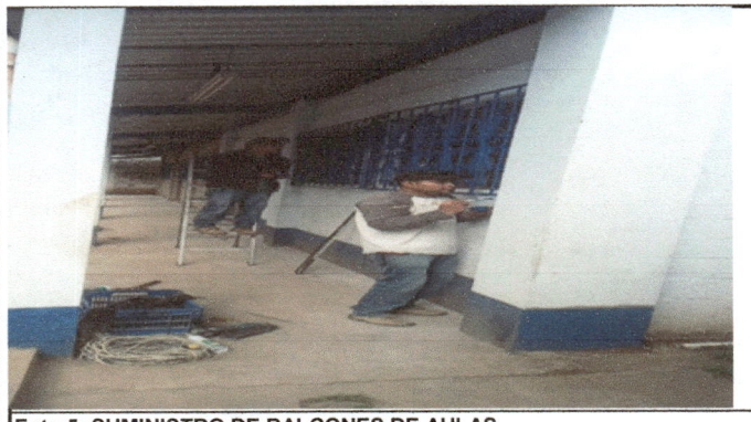
Foto 5: SUMINISTRO DE BALCONES DE AULAS.
