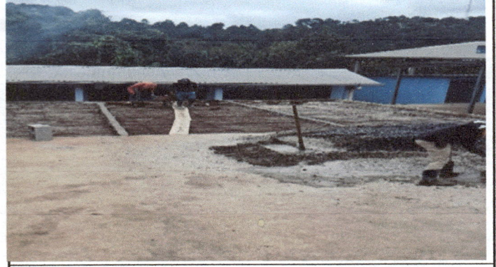
Foto 2: SUMINISTRO DE PISO DE TORTA DE CONCRETO PARA PATIO.
