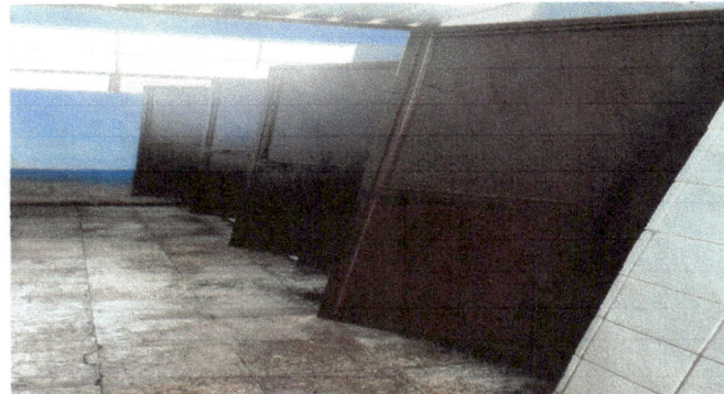
Foto 4: SUMINISTRO DE PISO CERAMICO DE SANITARIOS.
