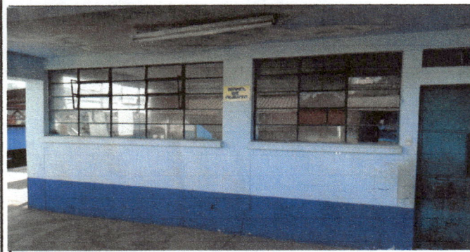
Foto 3: SUMINISTRO DE BALCONES DE AULAS.
