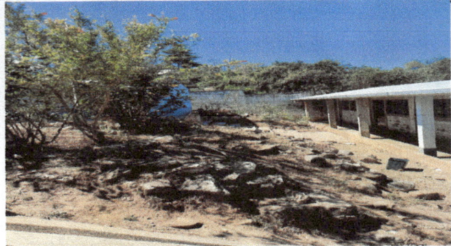
Foto 2: SUMINISTRO DE GRADERÍO PROTECCIÓN TALUD.
