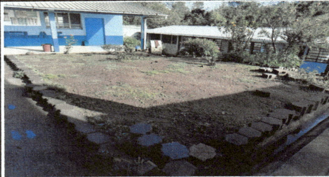
Foto 1: SUMINISTRO DE PISO DE TORTA DE CONCRETO PARA PATIO.
