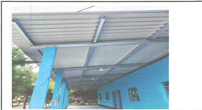
Foto1: Sustitucion de Techo de cocina con lamina Troquelada Alucink calibre 26
