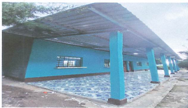
Foto 9: Pintada de dos mano de paredes de cocina con dos manos
