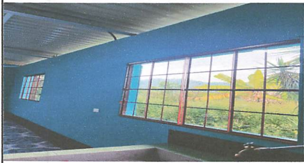
Foto 7: Sustitución de ventana de cocina de correrizo de 1.5x1.07 metros
