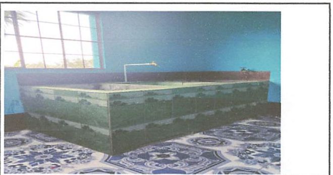
Foto 6: Fabricación de pila para agua con dos lavaderos con azulejo de 1.70 x 1 metro y de 0.80 metro de altura
