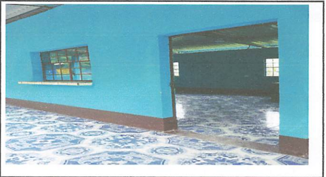
Foto 4: Sustitución de piso de cocina con piso ceramico
