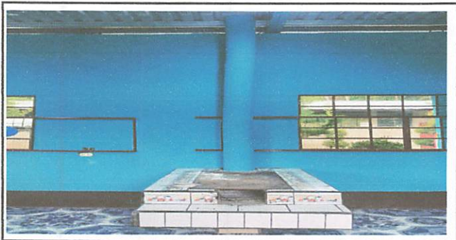
Foto 5: Mantenimiento de pollo de cocina con chimeneas de concreto
