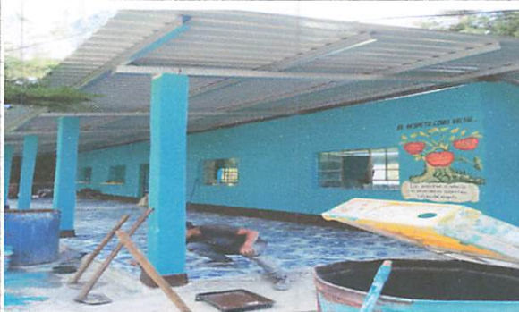
Foto 9: Pintada de dos mano de paredes de cocina con dos manos
