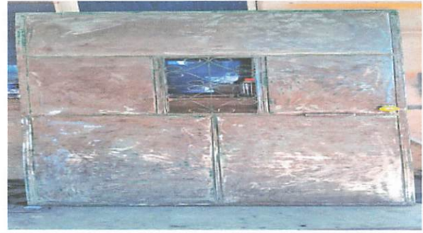
Foto 8: Mantenimiento de puertas con chapa yale de 2x1 metros
