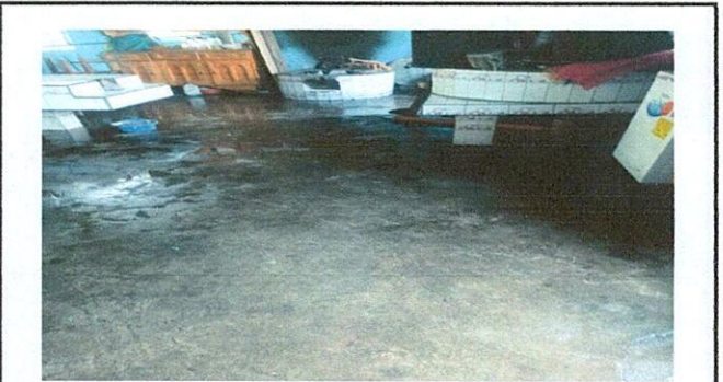
Foto 4: Sustitución de piso de cocina con piso ceramico
