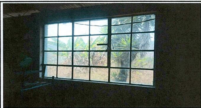
Foto 7: Sustitución de ventana de cocina de correrizo de 1.5x1.07 metros
