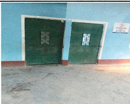
Foto 8: Mantenimiento de puertas con chapa yale de 2x1 metros
