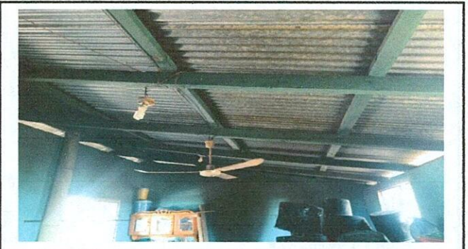
Foto 2: Sustitucion de estructura de techo de cocina con tubos galvanizada de 4x4 y 2x4 chapa 16
