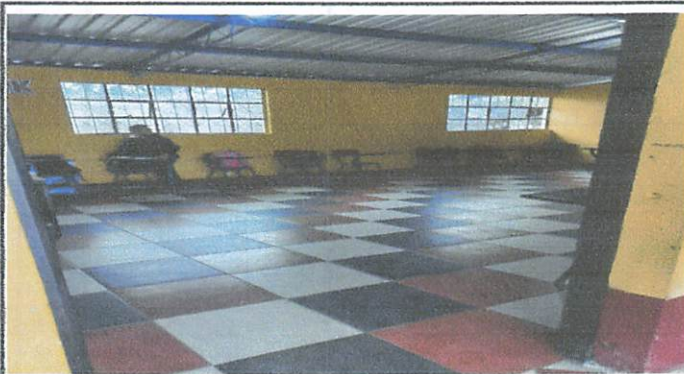
Foto 3: Piso ceramico antideslizante nuevo instalado en las aulas
