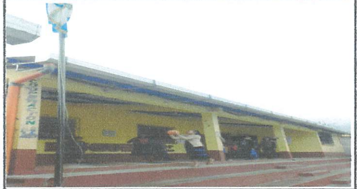
Foto 2: Canaletas para bajada de agua pluvial instaladas en su totalidad
