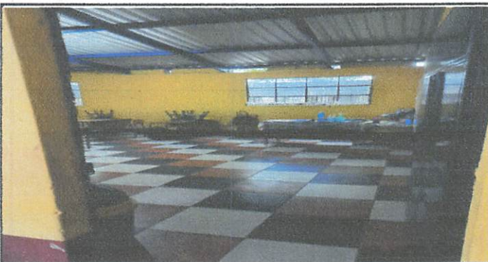
Foto 5: Piso ceramico antideslizantes nuevo instalado en aulas
