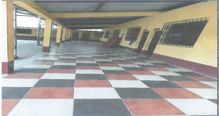
Foto 4: Piso ceramico antidelizante nuevo instalado en los corredores
