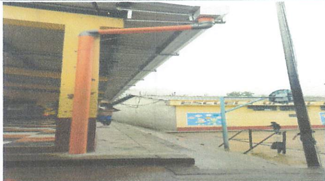
Foto1: Canaletas para bajada de agua pluvial instaladas en su totalidad
