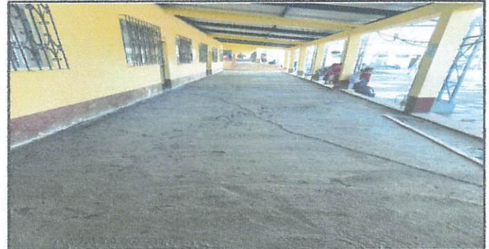
Foto 6: Fundicion de torta de cemento en corredores
