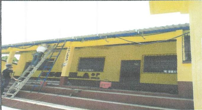
Foto 1: Instalacion de bases o soportes para las canaletas para bajada de agua pluvial
