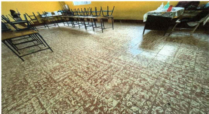
Foto 3: Sustitución de piso granito en aulas, dirección y bodega
