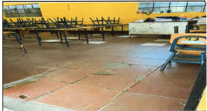
Foto 4: Sustitución de piso ceramico en un aula
