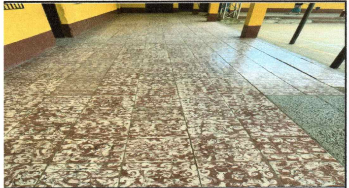
Foto 2: Sustitución de piso granito en todos los corredores
