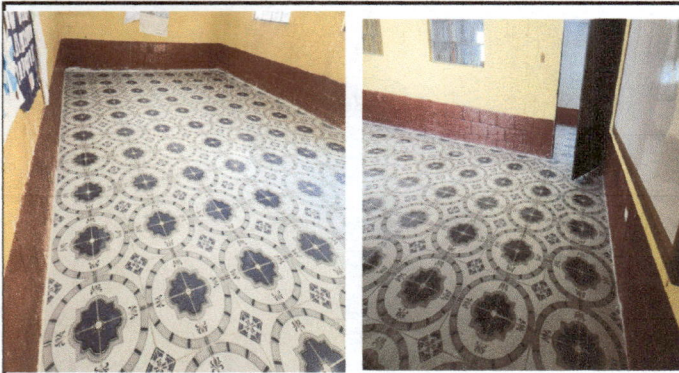
Así quedó la colocación de piso en las aulas
