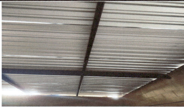
Techado de cocina terminado
