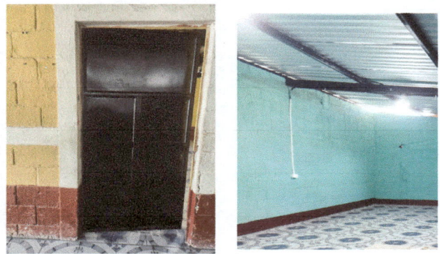
Las puertas terminadas y la instalación eléctrica termina
