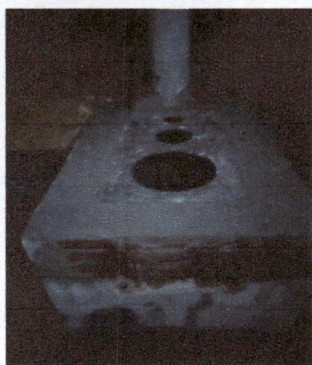
En este trabajo se esta realizando la sustitución de estufa mejorada, en donde se ve el pegado de azulejo
