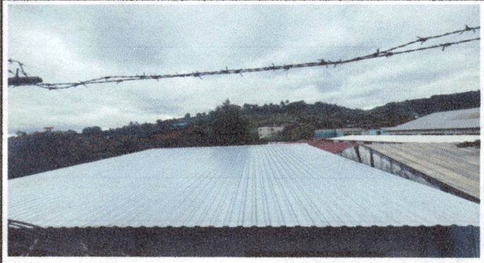
Foto2: Sustitución de techo de cocina con lamina Troquele Alucink calibre 26
