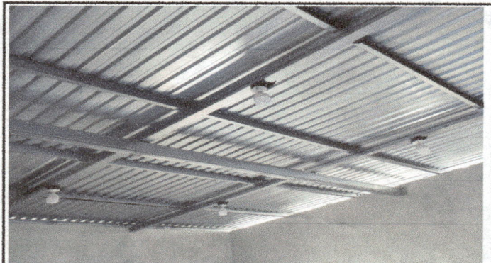
Foto 4: Viga principal de techo de 6x4
