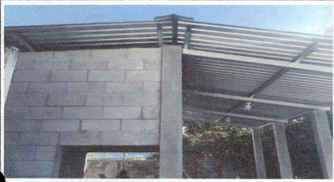
Foto1: Ampliación de cocina con paredes de block y corredor
