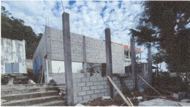
Foto 1: Ampliación de cocina con paredes de block y corredor
