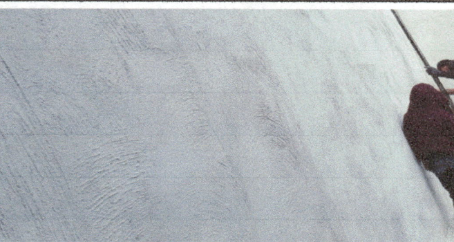
Foto 11: Pintada de pared de cocina con dos manos
