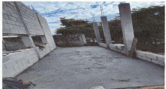
Foto 4: Viga principal de techo de 6x4
