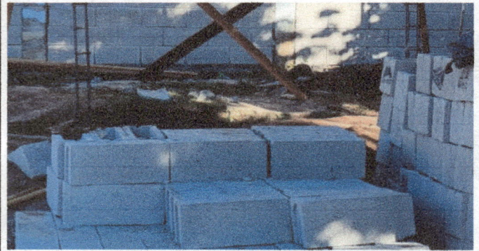
Foto 8: Fabricacion de pila para agua con 2 lavaderos de azulejo de 1.70 x 1 metro y de 0.80 metros de altura
