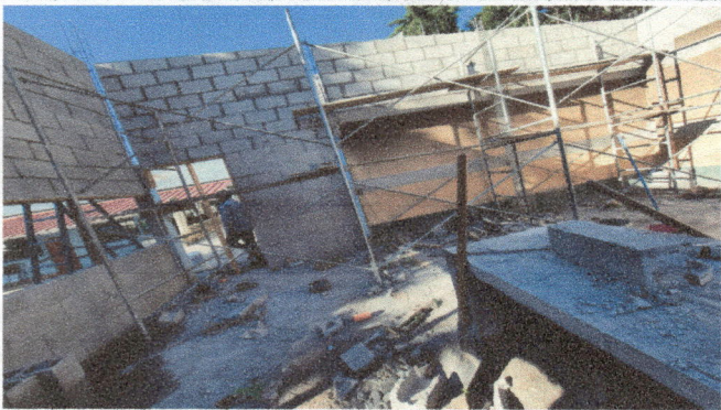
Foto 3: Sustitucion de estructura de techo de cocina de tubos galvanizada de 4x4 y 2x4 chapa 16 legitimo
