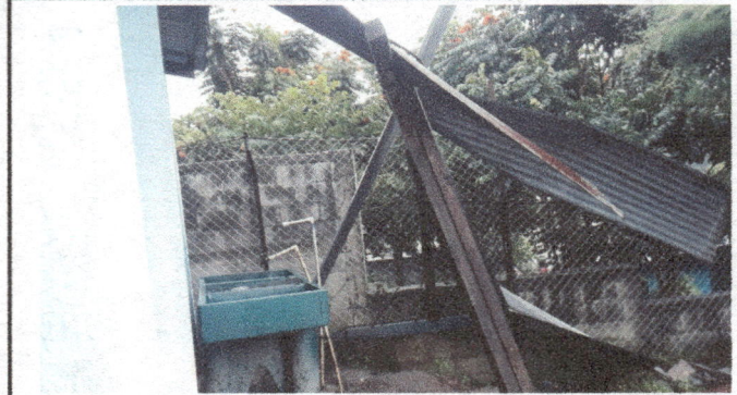
Foto 8: Fabricacion de pila para agua con 2 lavaderos de azulejo de 1.70 x 1 metro y de 0.80 metros de altura
