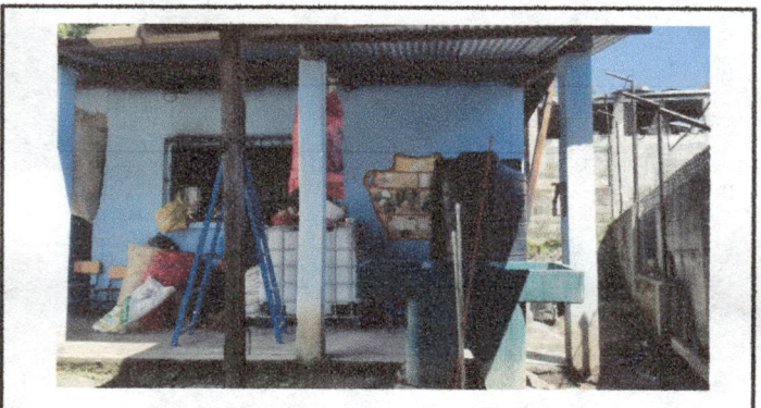
Foto 4: Viga principal de techo de 6x4
