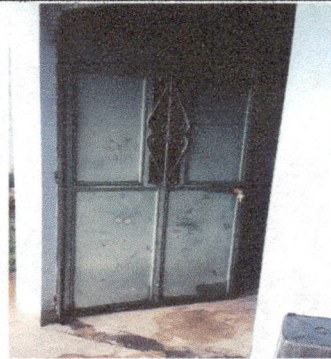
Foto 10: Mantenimiento de puertas con chapa yale 2x1 metro
