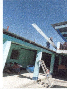
Foto 2: Suministro de material para sustitución de canal
