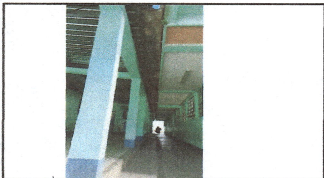
Foto 3: Suministro de material para instalación de bajadas pluviales.
