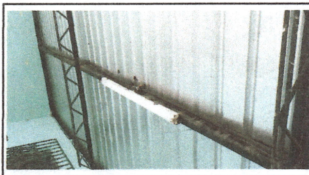
Foto 4: Suministro de material y mano de obras para sustitución de sistema eléctrico, consistentes en cableado y entubado.
