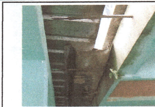
Foto 2: Suministro de material para sustitución de canal
