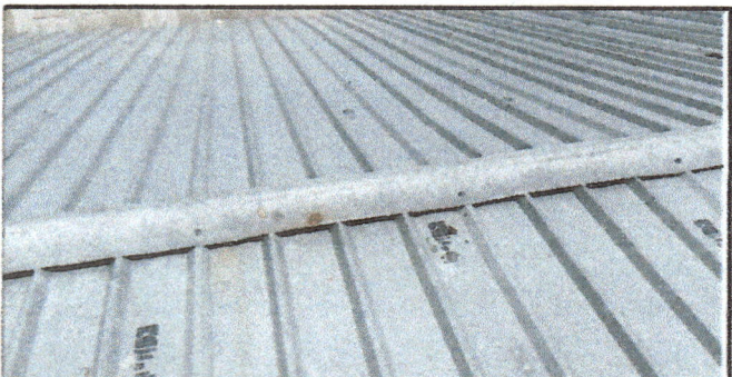
Foto 5: Suministro de material y mano de obras para instalación de capote.
