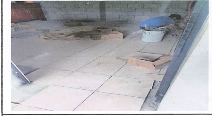
Foto 4: piso en la cocina
