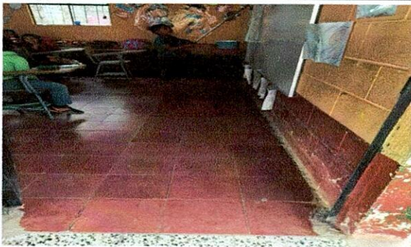
Foto 3: cambio de piso en las aulas
