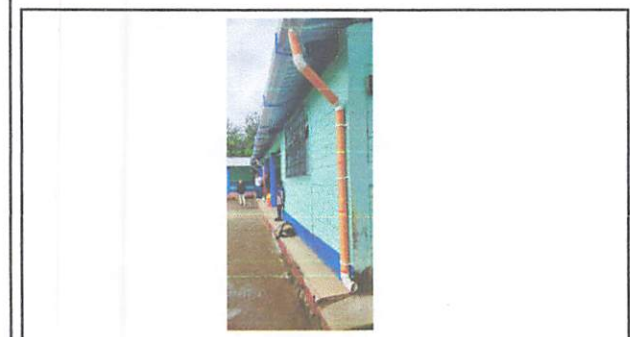
Foto 3: DES-INSTALACIÓN DE CANAL EXISTENTE + REINSTALACION
