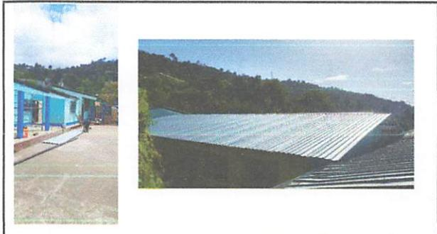
Foto 2: SUMINISTRO E INSTALACION DE CUBIERTA DE TECHADO CON LAMINA ALUZINC TROQUELADA CALIBRE 26
