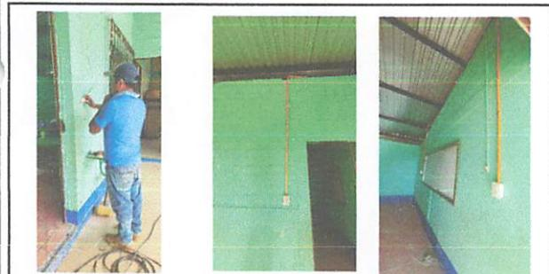
Foto 5: SUMINISTRO E INSTALACIÓN DE SISTEMA ELECTRICA ILUMINACIÓN
