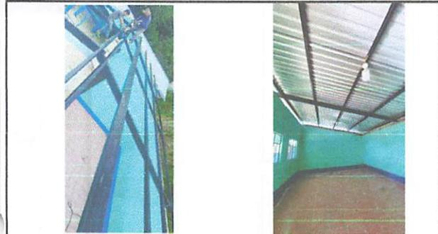
Foto 1: SUMINISTRO E INSTALACIÓN DE ESTRUCTURA METALICA EN TECHO DE AULAS CON COSTANERAS DE 2" X 3" LEGITIMO
