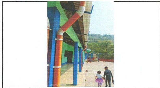
Foto 3: CANAL EXISTENTE SE DEBERA DES-INSTALAR Y RE-INSTALAR CON EL NUEVO TECHADO DE AULAS.
