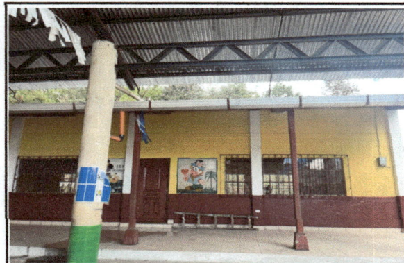
Foto 4: canales nuevos en corredor y tomacorriente nuevo.
