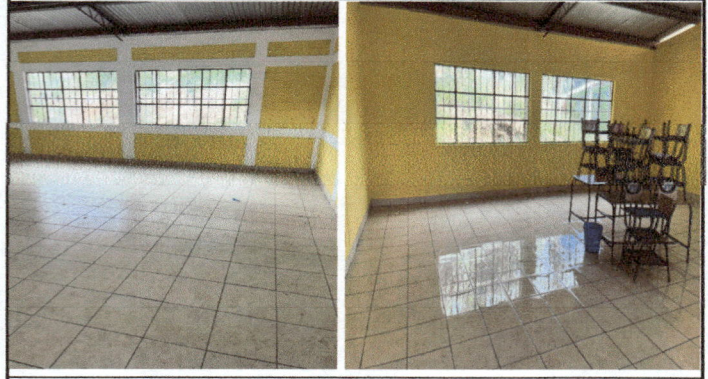
Foto 2: Piso cerámico nuevo en las 2 aulas.
