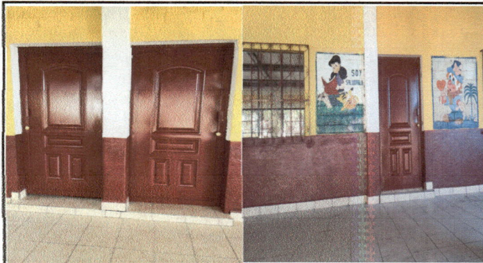
Foto 3: pintura nueva en las 2 aulas y dirección.
