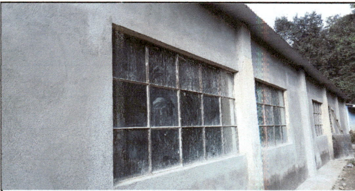
Foto 5: proceso de cernido de pared de las 2 aulas y dirección.
