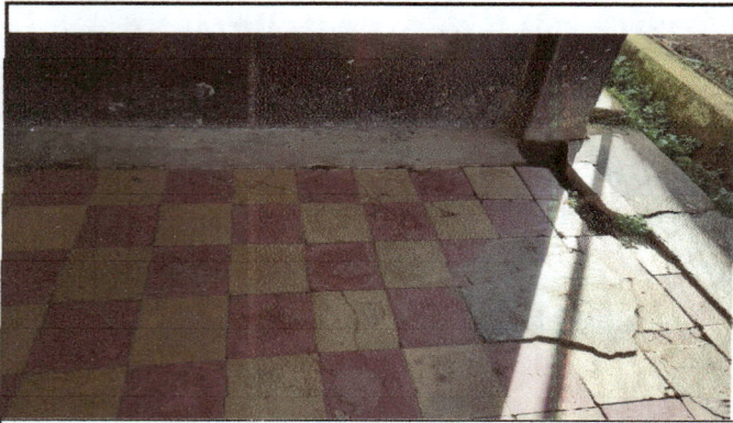
Foto1: PISO DETERIORADO, ES NECESARIO CAMBIO DE PISO EN CORREDOR DE SALONES DE CLASES
