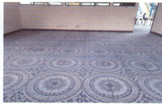
Foto 2: SUSTITUCION DE PISO POR PISO ANTIDESLIZANTE.
