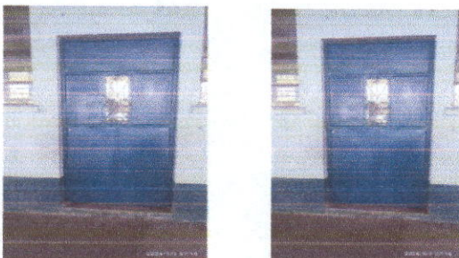
Foto 5: SUSTITUCION DE DOS PUERTAS EN MODULO No. 2
