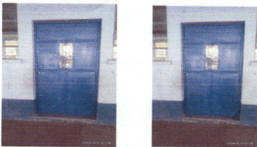
Foto 5: SUSTITUCION DE DOS PUERTAS EN MODULO No. 2
