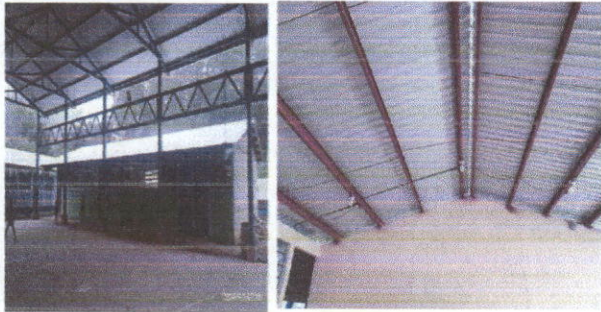
Foto1: SUSTITUCION DE LAMINA POR LAMINA TROQUELADA Y MANTENIMIENTO DE ESTRUCTURA PORTANTE DE METAL.
