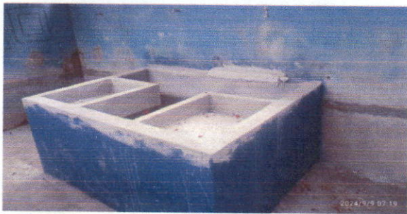
Foto 3: SUSTITUCION DE PILAS DETERIORADOS EXISTENTES, A PILA FABRICADO DE CONCRETO ARMADO CON REFUERZO ELECTROMALLA
