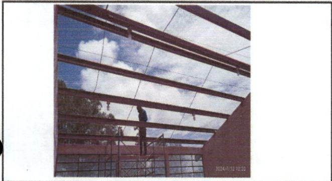
Foto 1: SUSTITUCION DE LAMINA POR LAMINA TROQUELADA Y MANTENIMIENTO DE ESTRUCTURA PORTANTE DE METAL.
