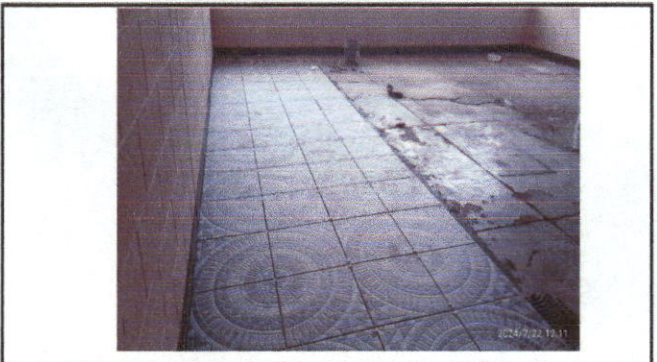
Foto 2: SUSTITUCION DE PISO POR PISO ANTIDESLIZANTE.
