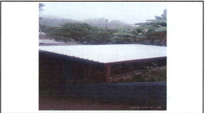
Foto 4: AREA DE PILETA SE NECESITA CAMBIO DE TECHO A METAL + LAMINA TROQUELADA, Y PISO TORTA DE CONCRETO.
