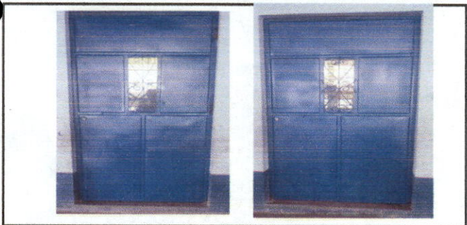
Foto 5: SUSTITUCION DE DOS PUERTAS EN MODULO No. 2
