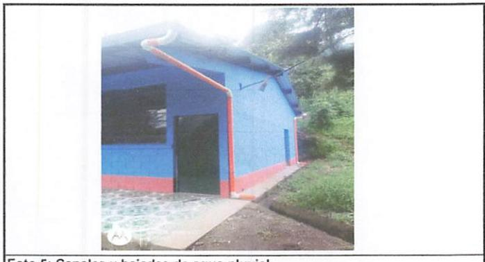
Foto 5: Canales y bajadas de agua pluvial
