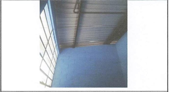
Foto 2: cubierta de láminas
