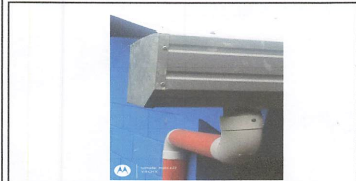
Foto 5: Canales y bajadas de agua pluvial
