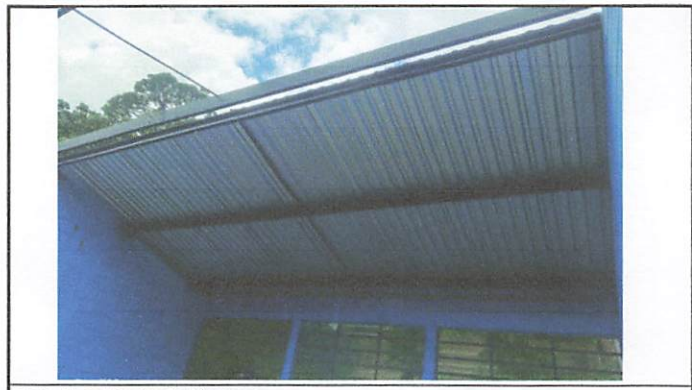
Foto 2: cubierta de láminas
