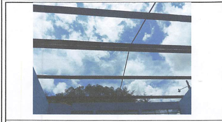
Foto 1: cubierta de láminas
