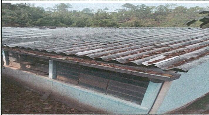
Foto 1: cubierta de láminas
