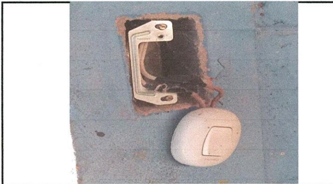
Foto 3: Reparacion del sistema electrico
