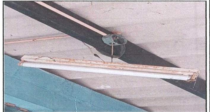
Foto 4: Estructura de techo
