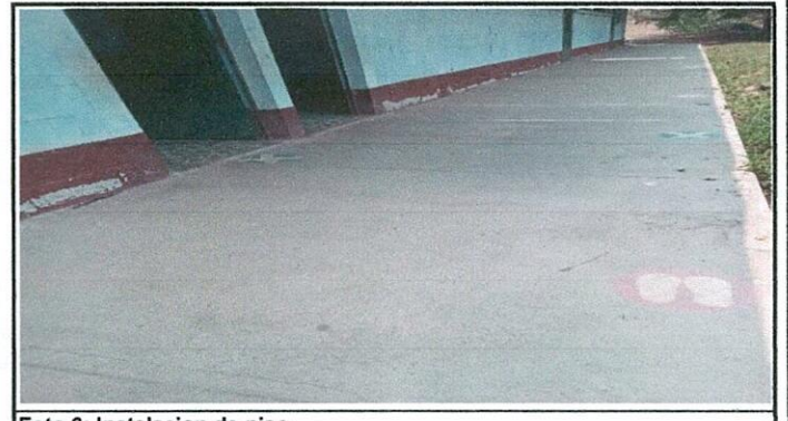
Foto 6: Instalacion de piso
