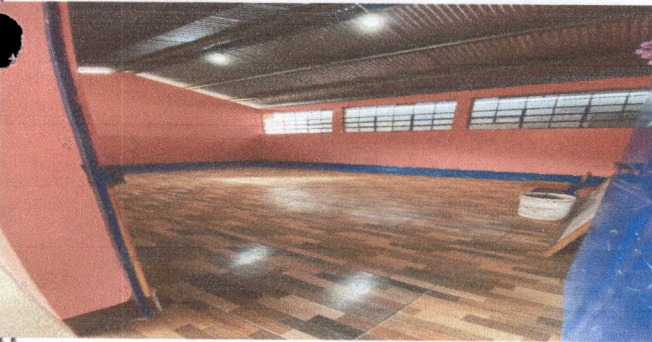
Foto 5: pintado de final interiores de aulas
