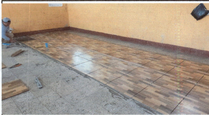
Foto1: colocación de azulejo en las aulas
