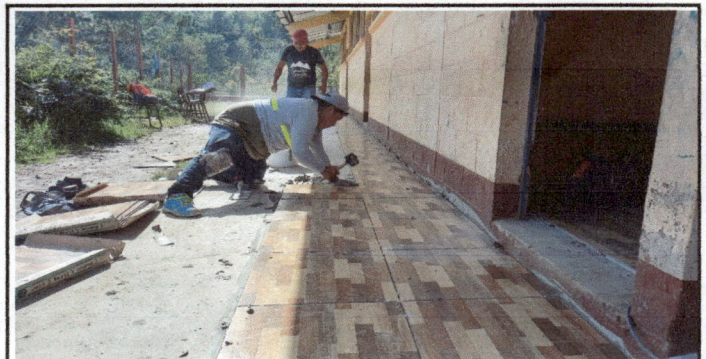
Foto 4: colocación de azulejos en corredor.
