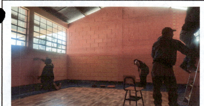
Foto 5: pintado de interior de aulas
