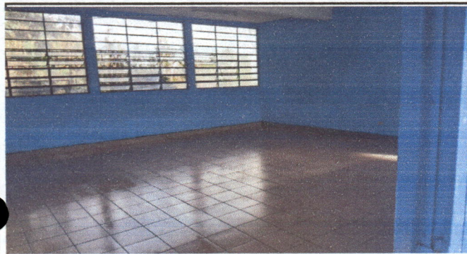
Foto 1: Suministro e instalación de piso cerámico en el aula de Cuarto Bachillerato.
