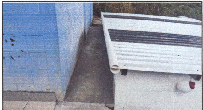
Foto 4: Mantenimiento de muro de contención.
