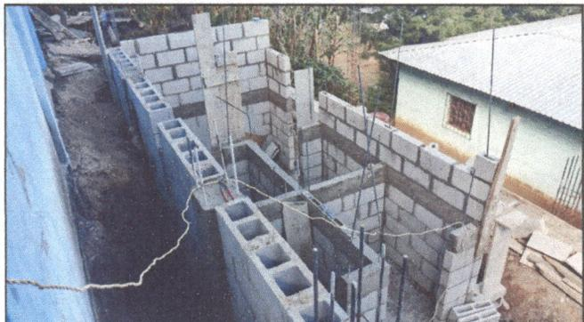
Foto 4: Mantenimiento de muro de contención.
