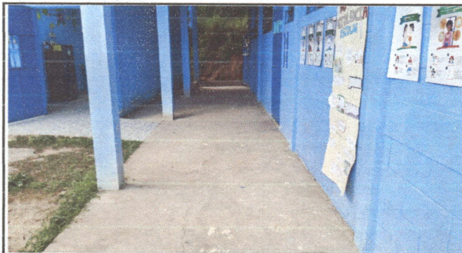
Foto 3: Suministro e instalación de piso cerámico en el corredor de las aulas.
