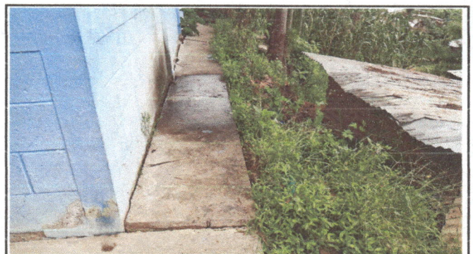
Foto 4: Mantenimiento de muro de contención.
