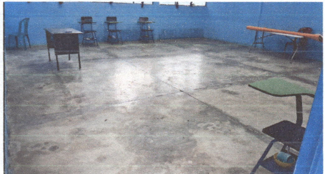
Foto 2: Suministro e instalación de piso cerámico en el aula de Quinto Bachillerato.
