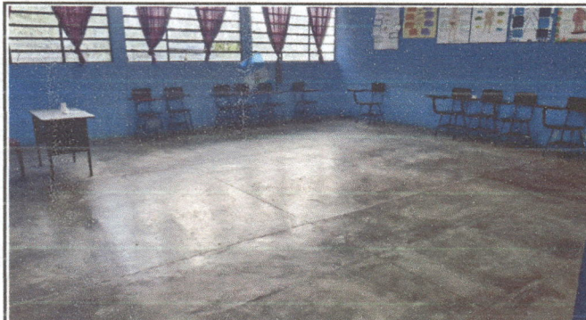
Foto 1: Suministro e instalación de piso cerámico en el aula de Cuarto Bachillerato.
