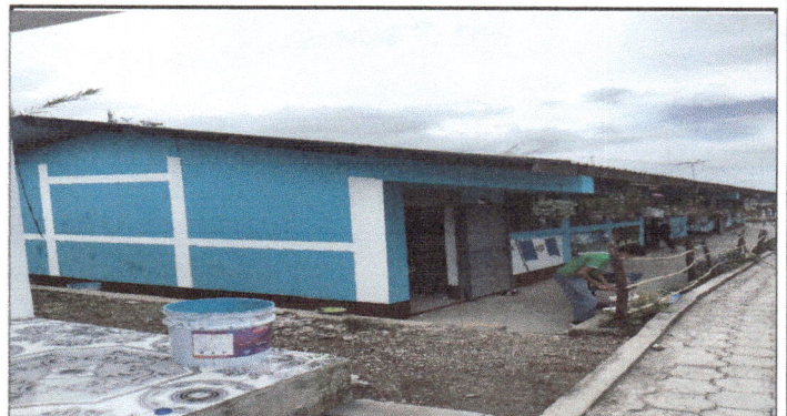
Foto 4: EL MURO DE LOS SALONES DE CLASE EN LA PARTE EXTERIOR YA CULMINANDO CON LA PINTURA
