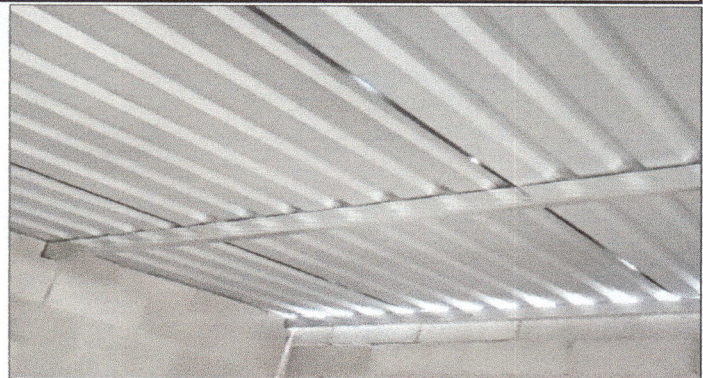
FOTO 8: CULMINACIÓN DEL TECHADO DE LA COCINA.
