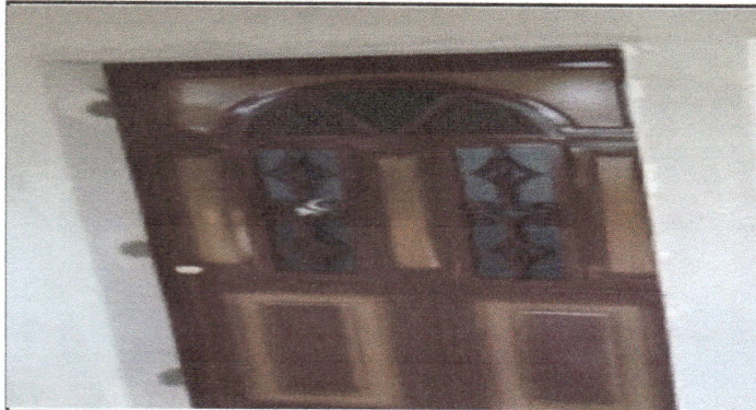
Foto 3: UNO DE LAS PUERTAS YA COLOCADAS
