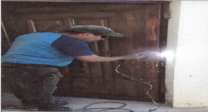
FOTO 7: COLOCACIÓN DE LAS NUEVAS PUERTAS
