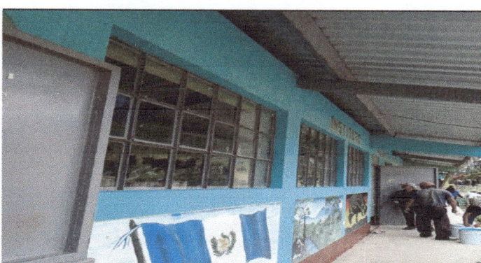
Foto 4: PARTES EXTERIOR DEL CENTRO EDUCATIVO PINTANDO
