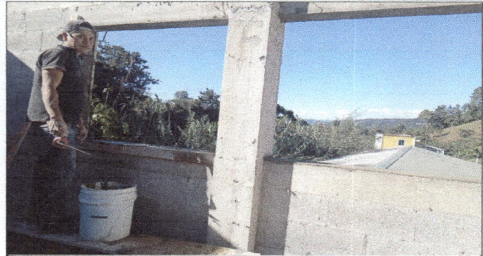
FOTO 8: ALGUNAS REMODALACIONES EN EL AREAS DE LAS VENTANAS
