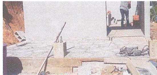
Foto 6: AREA DE CORREDOR DE COCINA EN NIVEL BAJO SE DEBE LEVANTAR UN MURO DE MAMPOSTERIO.
