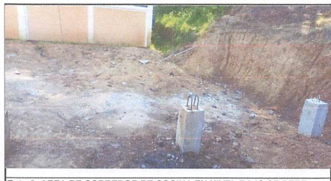
Foto 6: AREA DE CORREDOR DE COCINA EN NIVEL BAJO SE DEBE LEVANTAR UN MURO DE MAMPOSTERIA.
