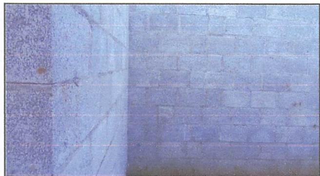
Foto 4: FALTA DE ACABADO EN PAREDES INTERIOR Y EXTERIOR
