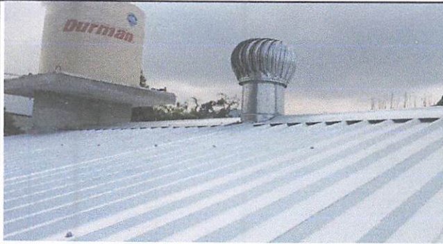
Foto 1: Cubierta de la cocina.
