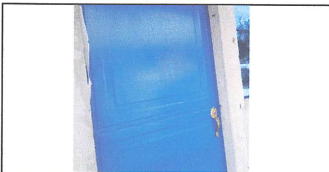
Foto 6: Puerta de la cocina instalada.
