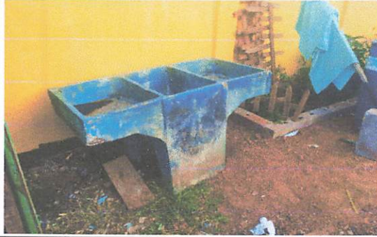
Foto1: Reparación y mantenimiento de agua.
