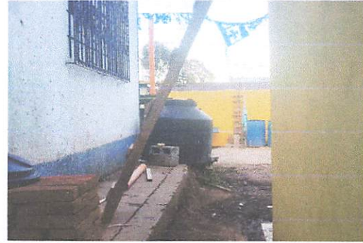
Foto 2: Reparación o sustitución de área de cocina.
