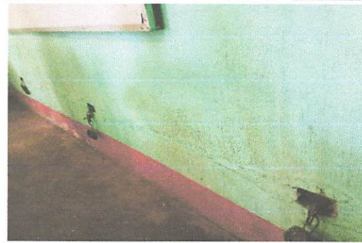
Foto 4: Reparación de sistema eléctrico.
