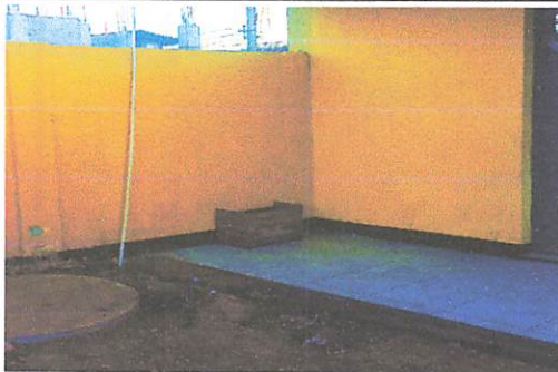
Foto 5: Estructura de Techo de cocina.
