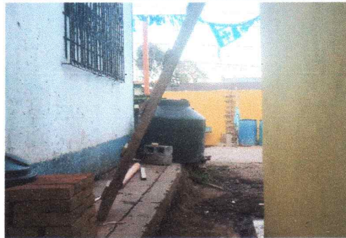
Foto 2: Reparación o sustitución de área de cocina.
