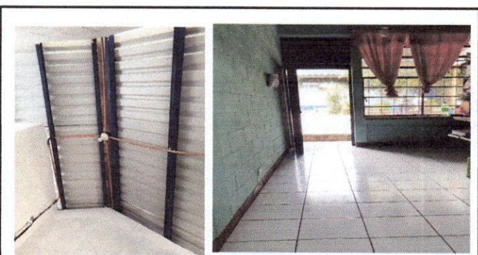
instalación de techo nuevo, instalación de cableado de energía eléctrica en sanitario y cocina, instalación de piso cerámico en dirección.
