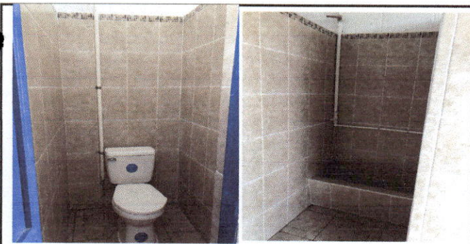
instalación de sanitarios nuevos en area de mujeres y hombres, construcción de migitorio en area de hombres, instalación de tubo de agua para las descargas
