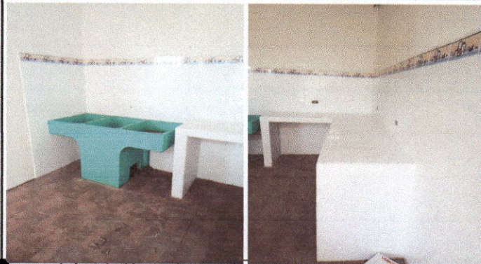
Se aprecia instalación de piso cerámico, azulejo, paredes repelladas, instalación de pila, de drenaje y agua potable, mueble de concreto forrado de azulejo.
