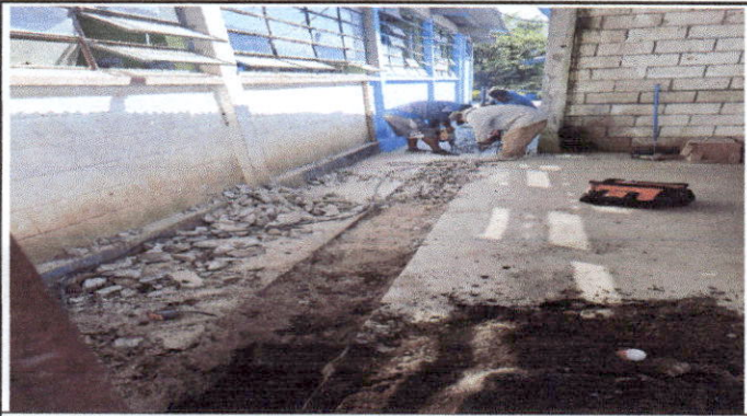
introduccion de drenaje y agua potable en la cocina
