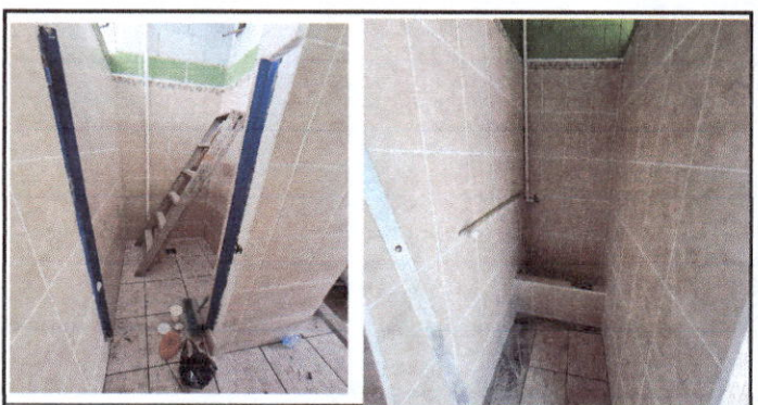
instalación de azulejo, piso ceramico en sanitarios tanto del area de mujeres como de hmbres. Construcción de mijitorio forrado de azulejo. Desmontaje y montaje de 5 sanitarios
