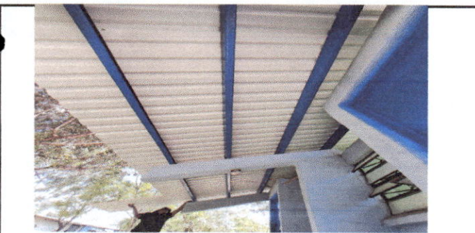
montaje nuevo de techo en el area de sanitarios
