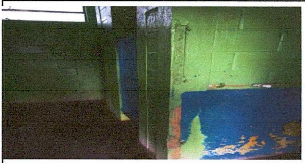
Esta fotografia muestra el area de sanitarios de hombres lo cual se cambiara dos sanitarios, se le colocara azulejo en las paredes y piso antideslizante.
