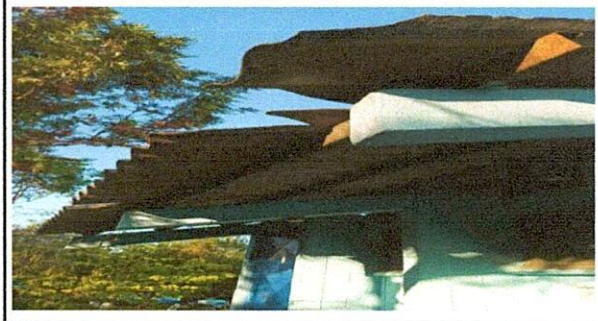
Se rempalzara el techo actual lo cual es de duralita y el remplazo sera de lamina.
