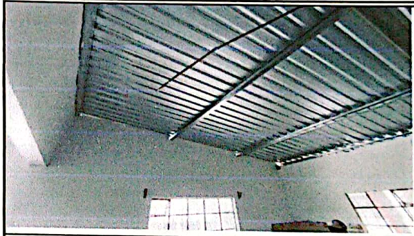
Foto 2: INSTALACIÓN DE LAMINA TROQUELADA Y ESTRUCTURA METALICA
