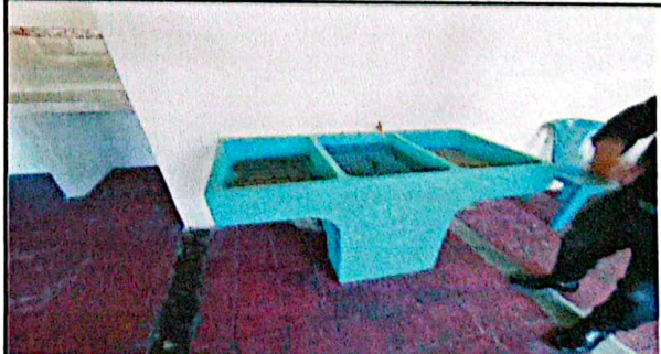
Foto 6: INSTALACIÓN DE PILA DE CONCRETO EN COCINA
