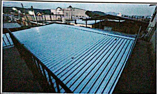
Foto 3: INSTALACIÓN DE LAMINA
