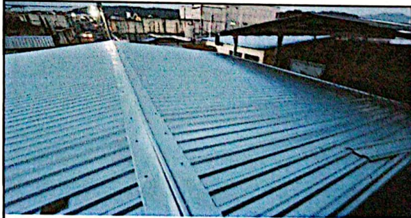
Foto 4: INSTALACIÓN DE LAMINA TROQUELADA Y CAPOTE
