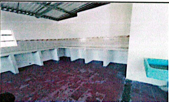
Foto 5: FABRICACIÓN DE MESA DE CONCRETO EN COCINA E INSTALACIÓN DE AZULEJO EN MURO
