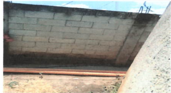
Foto 10: VISTA LATERAL DEL AREA A REMOZAR
