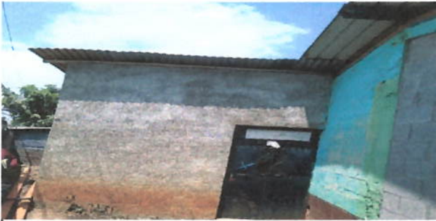
Foto 9: DEMOLISIÓN DE MURO PARA AMPLIACIÓN
