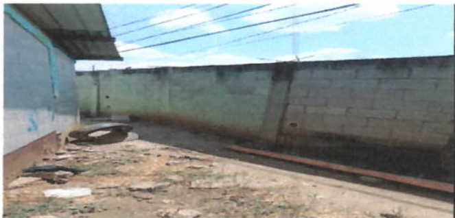
Foto 12: VISTA FRONTAL DEL AREA DONDE SE IMPLEMENTARA ESTRUCTURA Y LAMINA TROQUELADA
