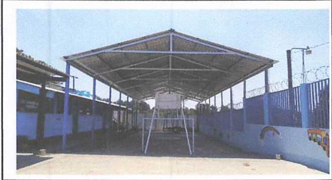
Foto1: Instalación de bases para el techo
