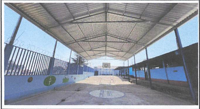
Foto 2: Instalación del techo
