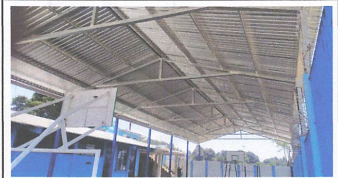
Foto 3: Finalización de techado
