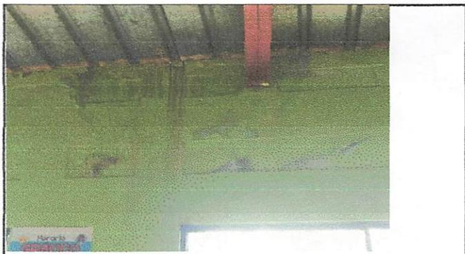
Foto 10: AULA No.8 DEL MODULO D TECHADO CON GOTERAS, COSTANERAS DETERIORADAS POR FALTA DE MANTENIMIENTO.
