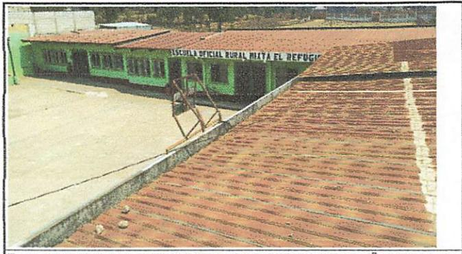
Foto 12: LAMINAS DETERIORADAS POR TIEMPO DE 25 AÑOS DE USO. CORREDOR MODULO B SIN CANALES NI BAJADA DE AGUA PLUVIAL
