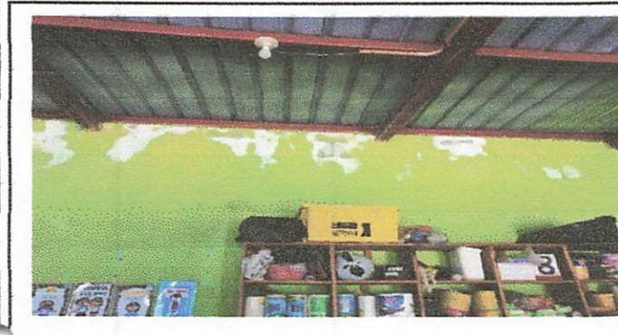
Foto 7: AULA No.5 DEL MODULO D TECHADO CON GOTERAS, COSTANERAS DETERIORADAS POR FALTA DE MANTENIMIENTO.
