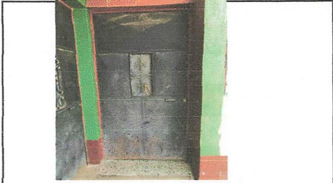
Foto 8: PUERTAS EN MAL ESTADO POR FALTA DE MANTENIMIENTO
