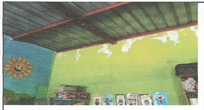
Foto 9: AULA No.7 DEL MODULO D TECHADO CON GOTERAS, COSTANERAS DETERIORADAS POR FALTA DE MANTENIMIENTO.
